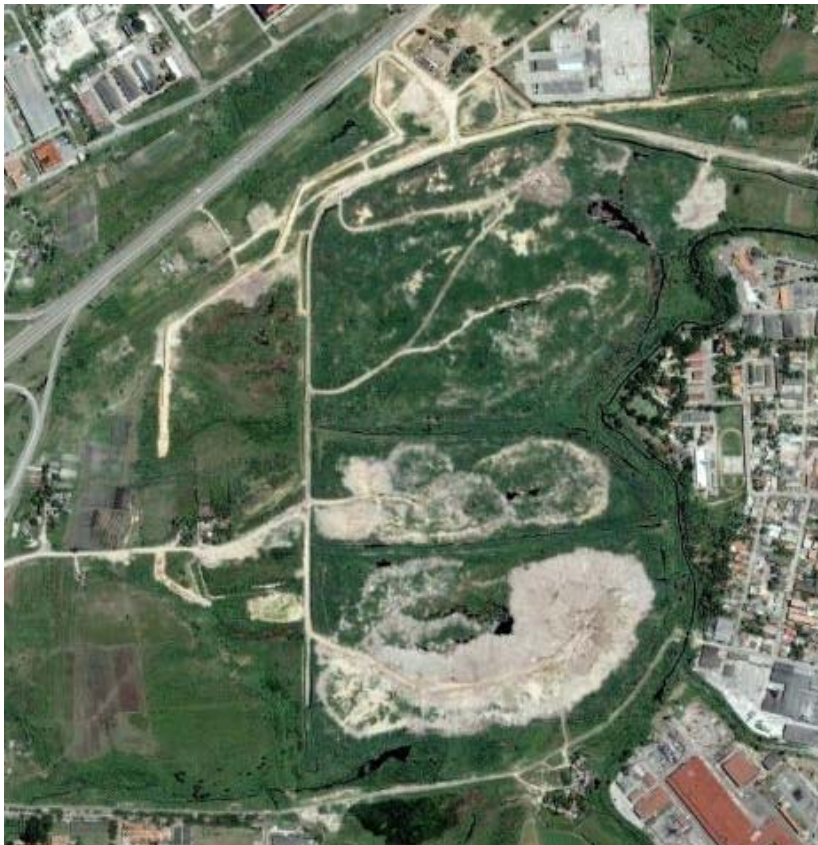
Figura 10: Vertedero Calle 100 (fuente: Google Earth)
